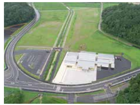
着々と工事が進む現場をドローンで空撮
